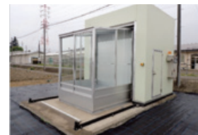
支援金を活用して設置した人工気象室（埼玉県農業技術研究センター【熊谷市】）
